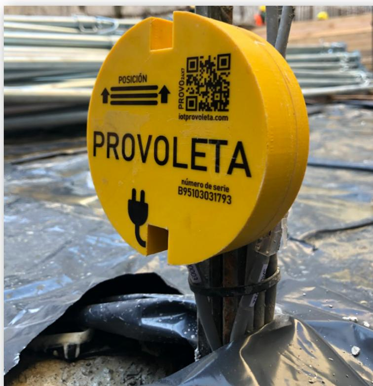
***“IoT PROVOLETA permite estimar la resistencia real de la estructura teniendo en cuenta la condiciones reales de obra: colocación, compactación y terminación”***
